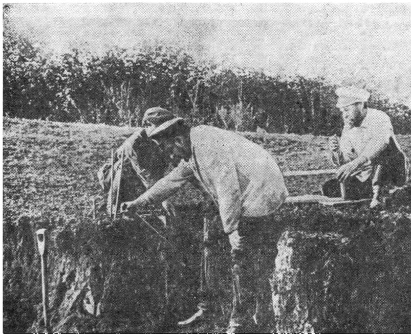
Испытание нового способа выемки почвенного монолита металлической рамкой с винтовым устройством (1899 г.). (В центре — В. Р. Вильямс).
