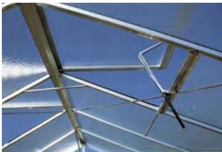
Рис. 2. Общий вид гидравлической вентиляции тепличного помещения
