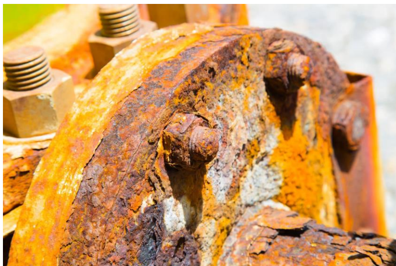
Рисунок 1 – Внешний вид коррозионных поражений сельскохозяйственной техники
