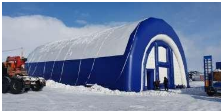
Рис. 1 - Надувной ремонтный бокс для обслуживания и ремонта СДМ
