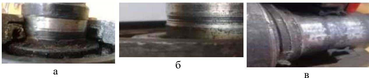
Рис. 1 – Дефекты валов в зоне контакта с манжетами:
