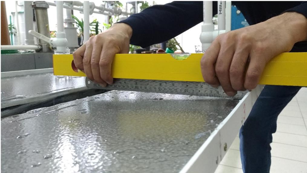
*Рис. В.21 - . Изменение уклона прилегающей к установке площадки.*
