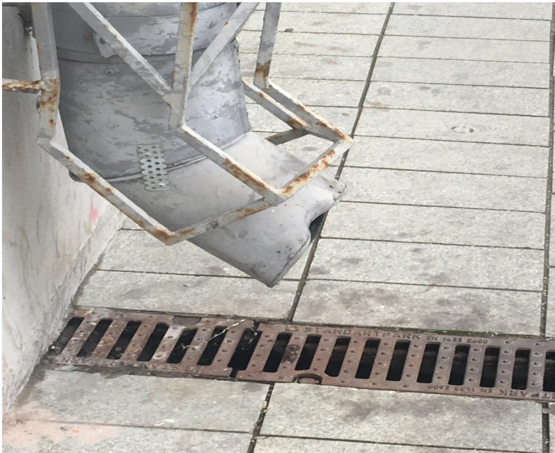
Рис. А.8 - Отвод воды с кровли здания открытым выпуском в лоток.
