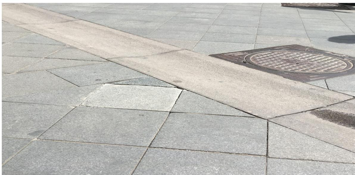
Рис. А.2 - Открытый лоток малой глубины, сопряженный с мощением.
