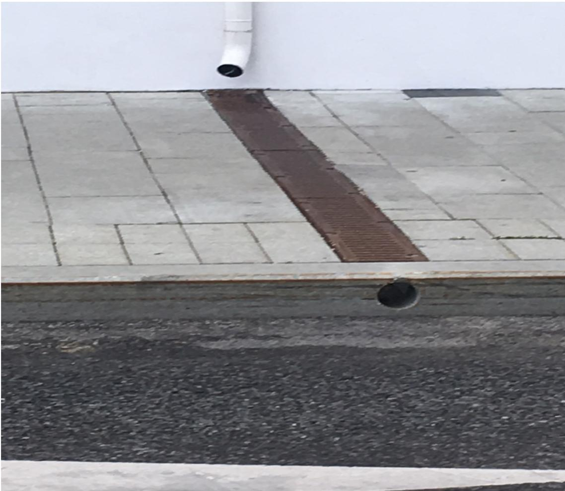
Рис. А.9 - Отвод воды с кровли здания лотком на проезжую часть.
