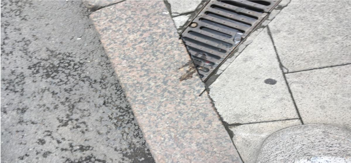
Рис. А.7 - Лоток доведен до проезжей части, но выпуск замоноличен.
