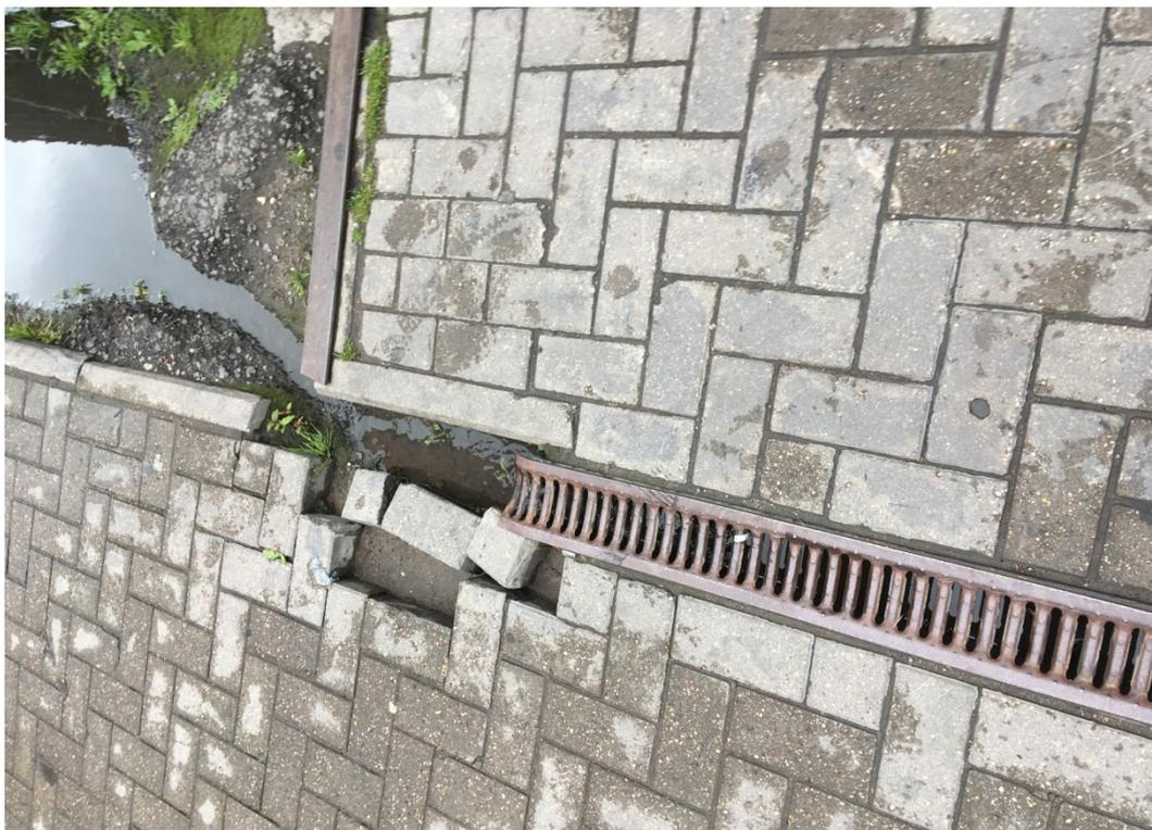
Рис. А.5 - Размыв лотком брусчатка и газона.
