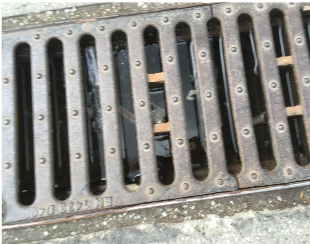
Рис. А.6 - Засор лотка при малых уклонах.
