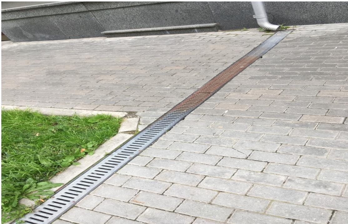
Рис. А.10 - Отвод воды с кровли здания лотком в закрытую сеть канализации.
