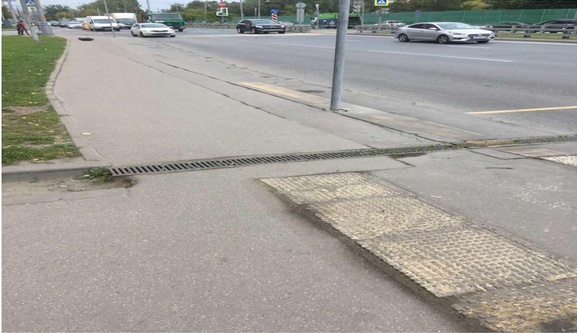
Рис. А.11 - Перепуск воды с автостоянки на проезжую часть лотком, Москва.
