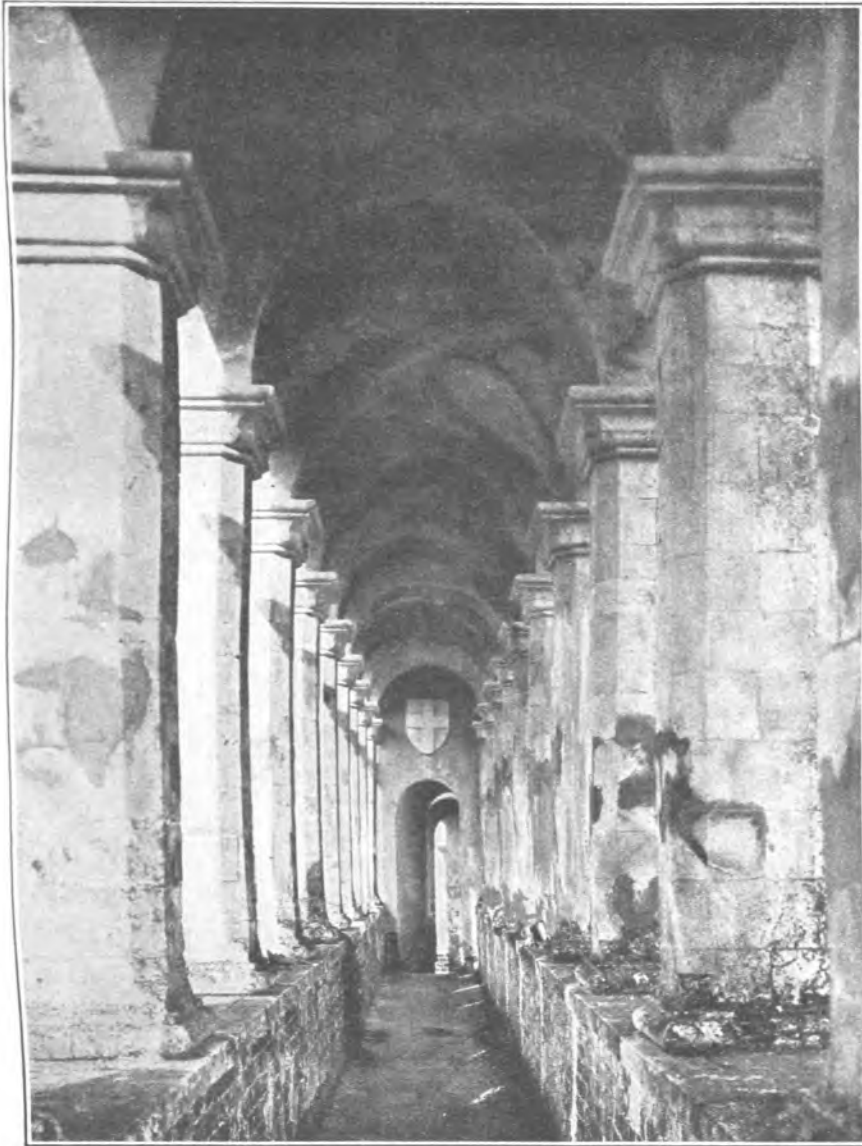
Колонна на мосту въ Марѣнѣ, пмѣнія Паниныхъ. (Съ фот.).
