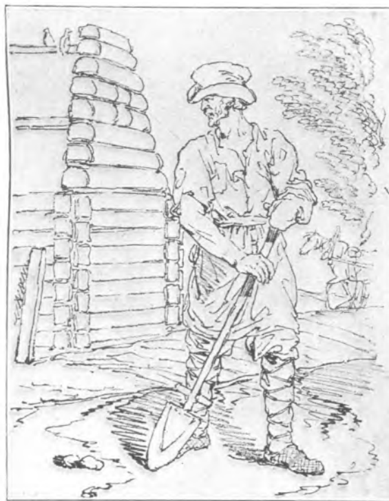
За земляными работами (Аткинсонъ).
