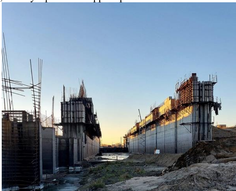
Рисунок 5 - Строительная готовность судоходного шлюза (2022 год)
