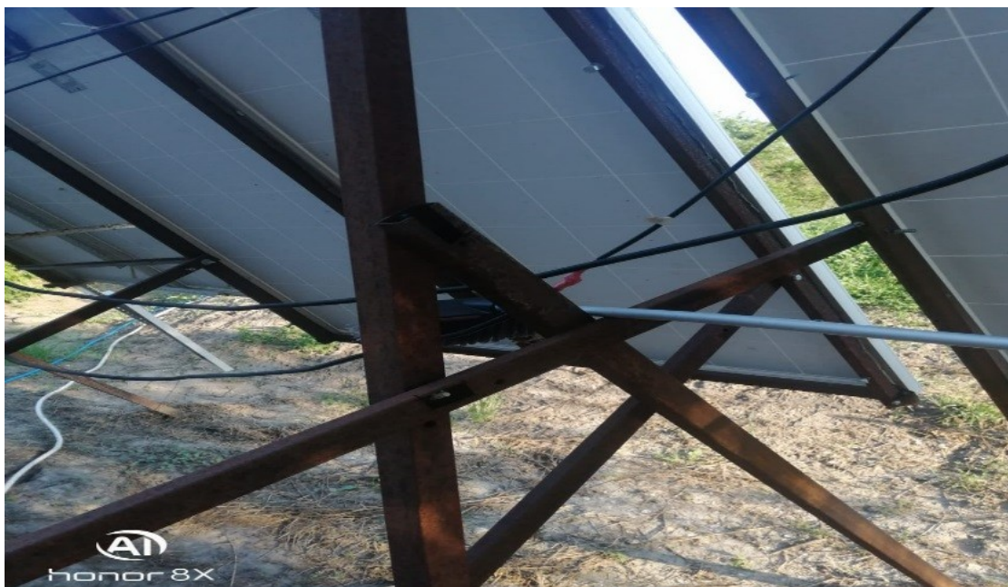
Рисунок 85. – Узлы соединения каркаса для установки солнечных модулей
