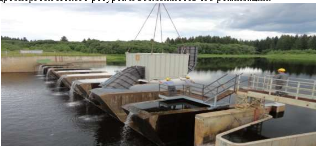
Рисунок 1- Установка энергетического блока мини ГЭС на полигональный водосброс р. Нерль
