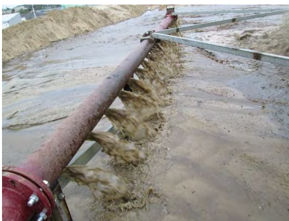
Рисунок 1 – Процесс намыва боковых призм защитной дамбы
