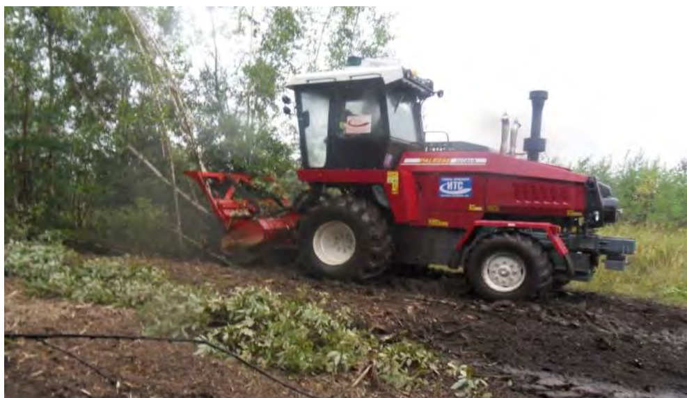
Рисунок 1 – Мульчер при выполнении процесса расчистки
