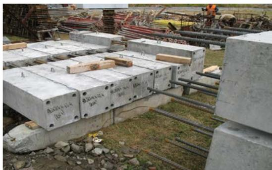
**Рис. 1. Колонны со штепсельным стыком**
