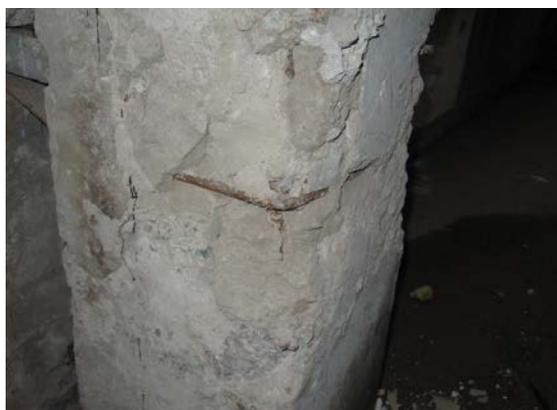
**Рис. 1. Сколы бетона несущей железобетонной колонны**
