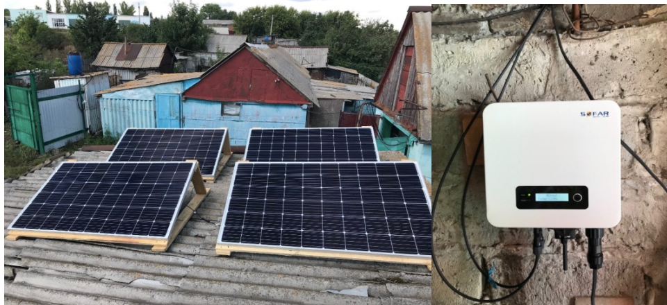
Рисунок 67. – Установленные солнечные панели и инвертор Sofar СФУ
