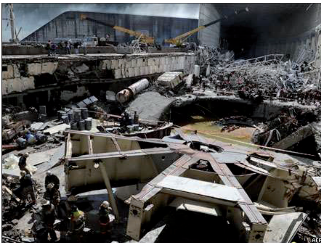
Рис. 4.15. Машинный зал СШ ГЭС. Вид после аварии 17 августа 2009 г.
