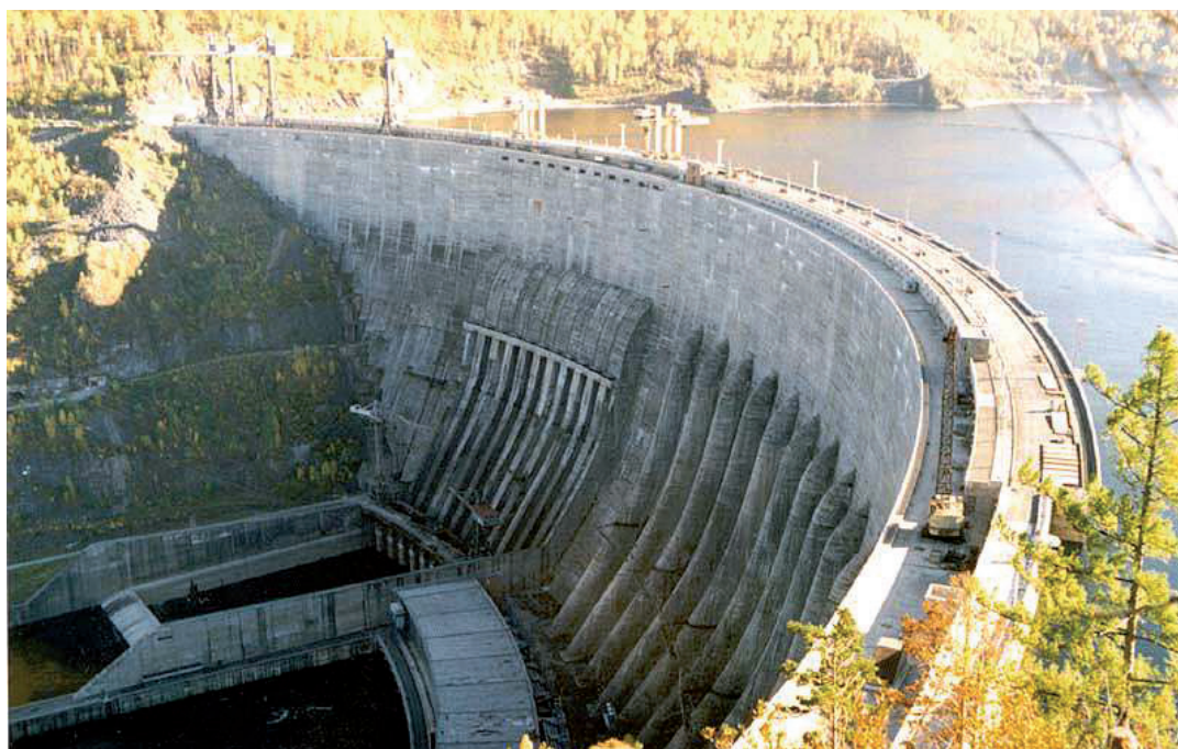
Рис. 4.18. Вид на плотину СШ ГЭС с левого берега Енисея. Высота сооружения 242 м, длина по гребню 1074,4 м, ширина по основанию – 105,7 м и по гребню — 25 м.
