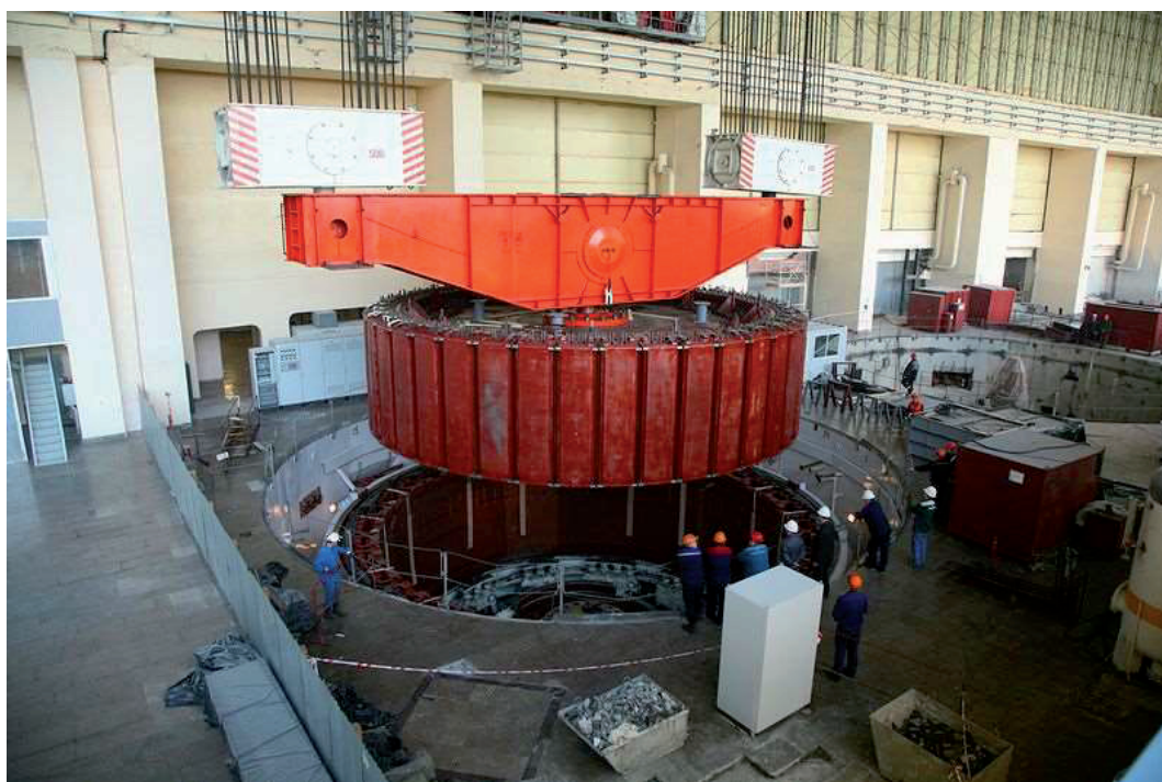
Рис. 4.16. Установка ротора ( 2p = 42 ) в кратер 4-го гидроагрегата СШ ГЭС; восстановительные работы 12 мая 2010 г.
