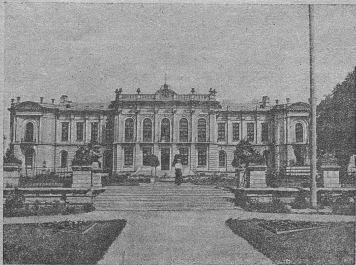
Фасад главного здания со стороны парка.
