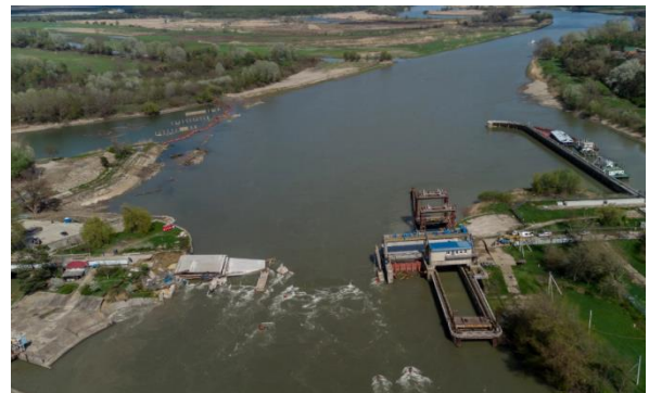
г) 22 апреля 2022 года обрушение плотины Федоровского гидроузла
