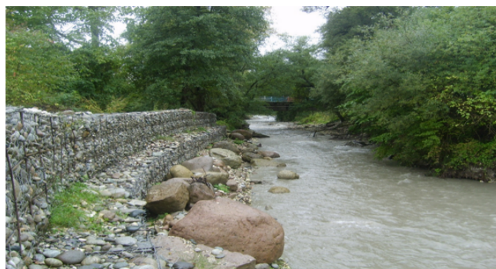
Рис. 5. Участок берегоукрепительного сооружения на р. Шалущка, построенный с возведением подпорных стен из габионов по патенту № 2336389 (фото авторов)
