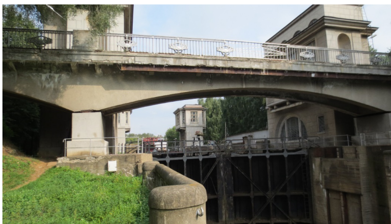
Рис. 1. Общий вид моста в составе шлюза (фото Б.А. Бондарева)
