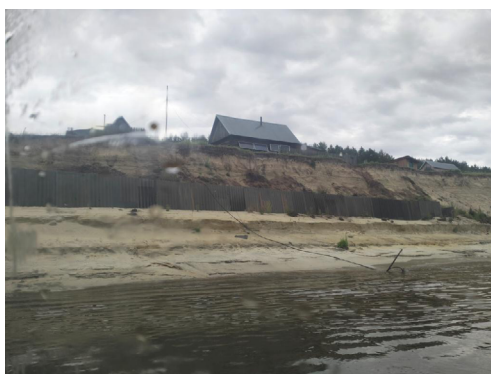
Берегозащитные сооружения в виде тонкой стенки (поселок Вар-Бор) Shore protection structures in the form of a thin wall (Var-Bor settlement)
