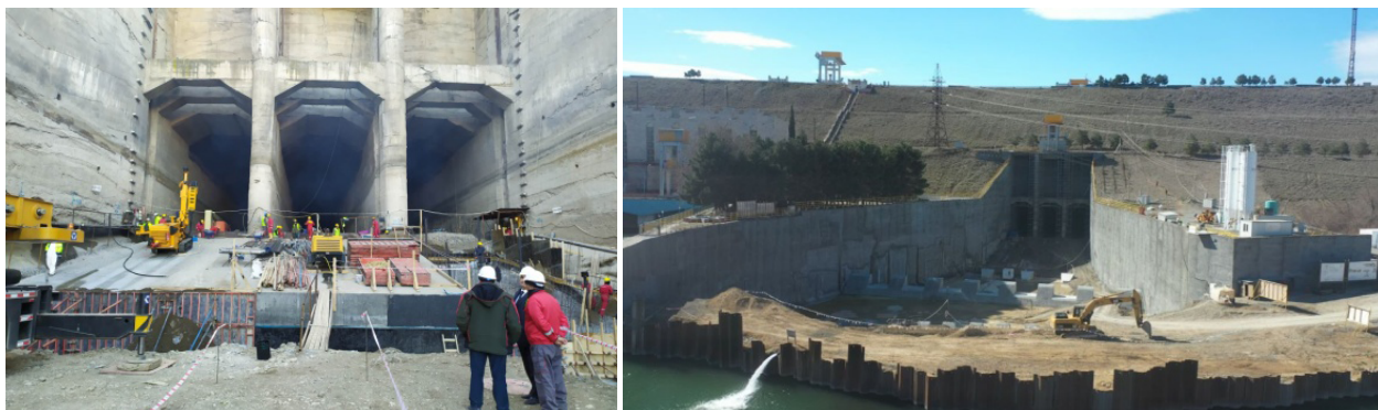
Рис. 2. Вид со стороны нижнего бьефа на начальные этапы работ по реновации водобойного участка водосброса, 2021 г. (фото Azerenerji OSC)
