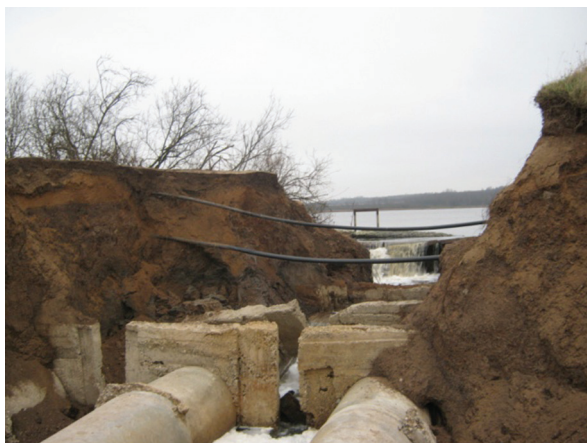
Рис. 1. Аварии на бесхозных грунтовых плотинах
