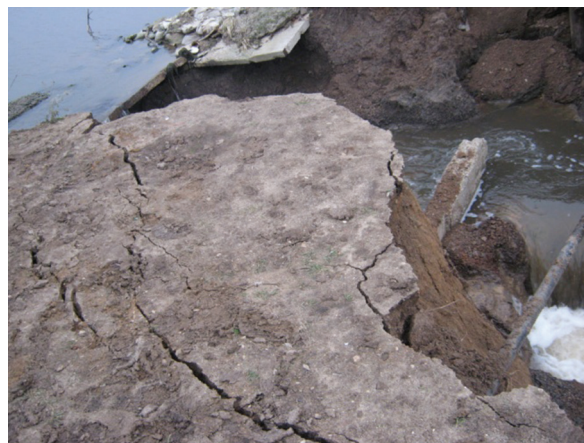
Рис. 1. Аварии на бесхозных грунтовых плотинах
