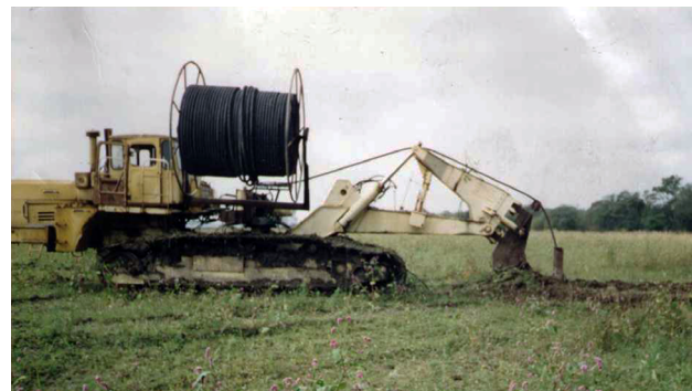
Рис. 1. Строительство бестраншейного пластмассового дренажа на участке Тихоокеанского комплекса
