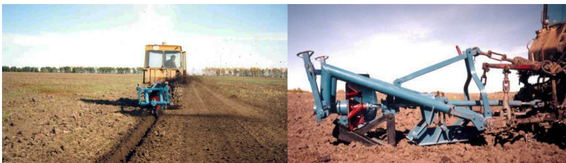
Рис. 2. Технология устройства щелевого дренажа с применением щелереза ЩМ-14 конструкции ДальНИИГиМ
