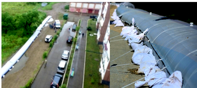
Рис. 12. Водоналивная дамба из эластичного материала, уложенная по бровке берега р. Комаровки (2019 г.) в г. Уссурийске для защиты территории от затопления
