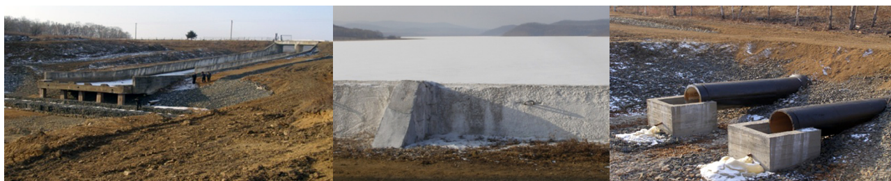
Рис. 13. Берестовецкое водохранилище, быстроток (слева) и трубчатые элементы донного водовыпуска (справа)
