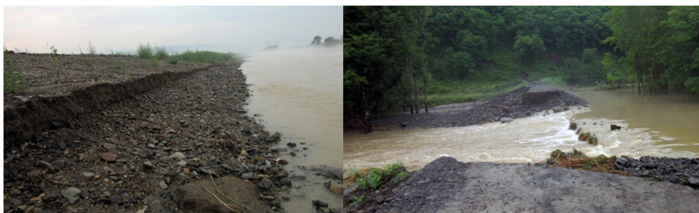
Рис. 15. Частично разрушенная паводком защитная дамба обвалования мелиоративной системы «Элитная» на р. Уссури
