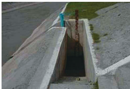
Рис. 1. Успокоительный колодец с уровнемерной рейкой [4]
