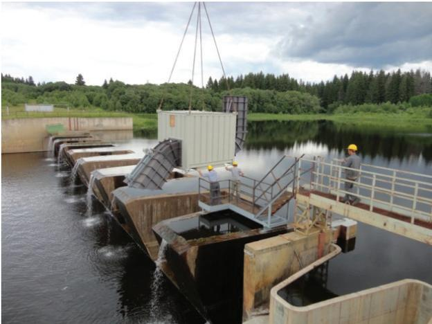
**Рис. 1. Установка энергетического блока мини ГЭС на полигональный водосброс р. Нерль. Контейнерное исполнение с ортогональной турбиной в нижнем бьефе**
