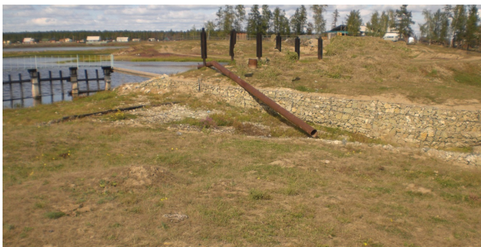
Рис. 1. Гидроузел Куогалы со стороны нижнего бьефа
