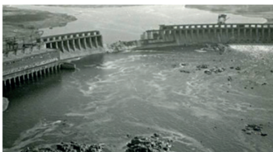
Рис. 2. Разрушение объектов инфраструктуры в нижнем бьефе после прорыва плотин
