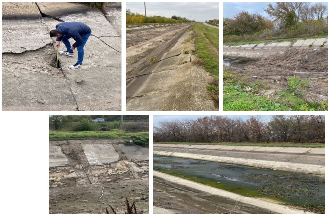
Рис. 1. Визуальный осмотр оросительных каналов (Энгельский филиал ФГБУ «Управление Саратовмелиоводхоз»)
