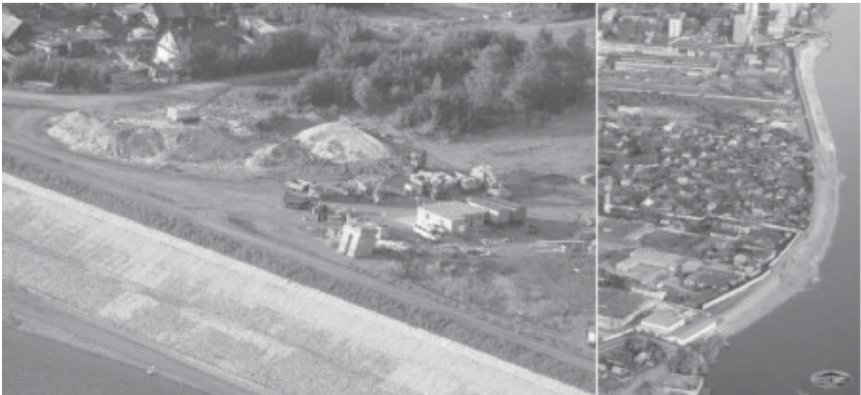
Рис. 4. Внешний вид дамбы в процессе строительства укрепления откосов матрацами Рено
