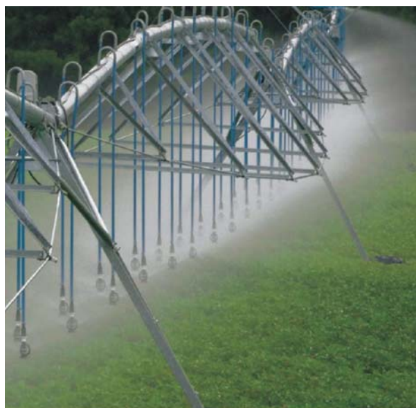
Рис. 3. Присоединение дождеобразующих устройств приземного водораспределения
