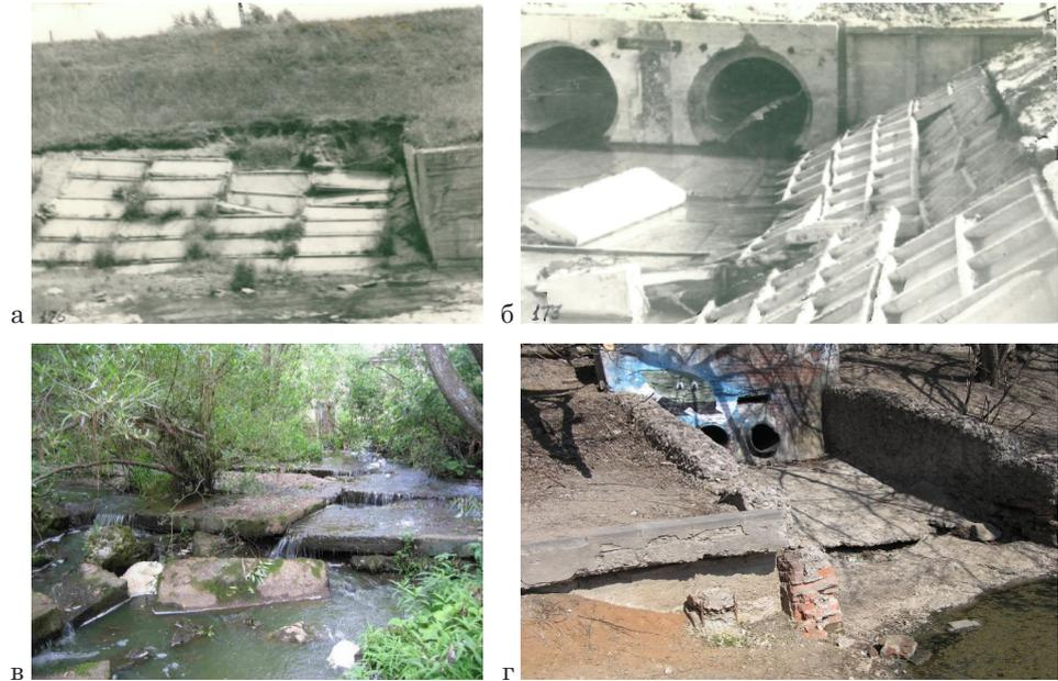
Рис. 1. Разрушение крепления за водосборами, обследованными в разные годы на гидроузлах АПК (фото авторов):
