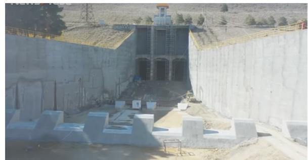
Рис. 2. Реконструкция бетонного крепления за 3-очковым водосбором Шамкирского гидроузла, март 2021 г.
