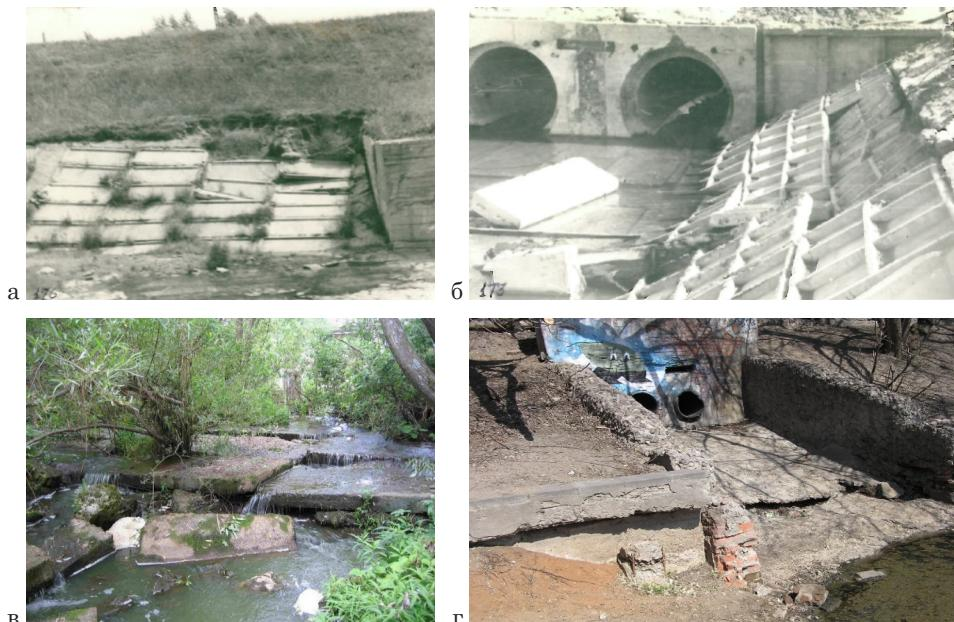
Рис. 1. Разрушение крепления за водосбросами, обследованными в разные годы на гидроузлах АПК (фото авторов):
