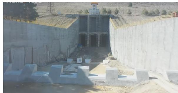
Рис. 2. Реконструкция бетонного крепления за 3-очковым водосбросом Шамкирского гидроузла, март 2021 г.
