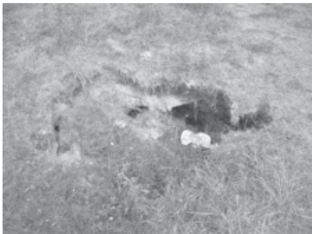
Рис. 2. Провальная воронка на верховом откосе справа от оси водосброса (30 августа 2005 г.)
