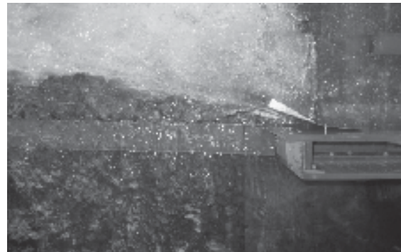
Рис. 3. Общий вид потока на выходе из водосброса № 2 с использованием отклонителя. Начало пропуска расходов с первого пролета относительно оси турбинных камер
