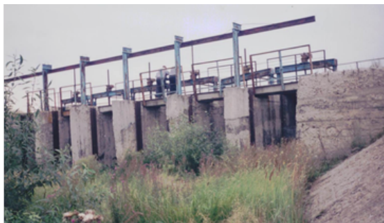
а) водосбросное сооружение. Вид с верхнего бьефа a) Spillway structure. View from the upper pool
