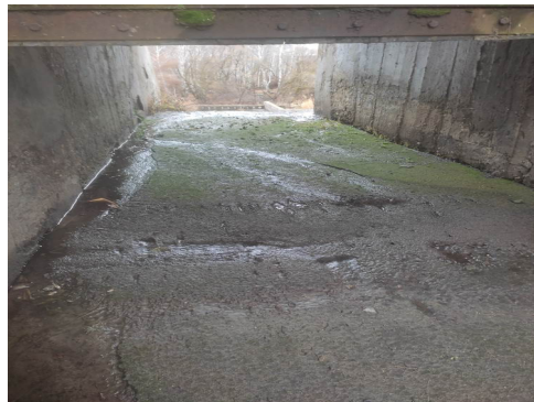
в) зарастание подводящего канала водосбросного сооружения и заиленность дна быстротока
