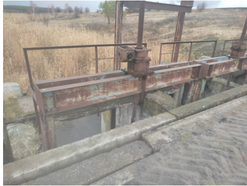
а) подъемный механизм гидромеханического оборудования отсутствует и находится в неработоспособном состоянии
