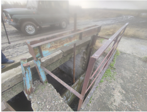
а) подъемный механизм гидромеханического оборудования отсутствует и находится в неработоспособном состоянии
