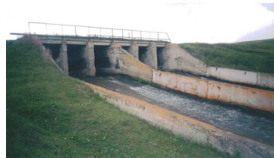
б) водосбросное сооружение. Вид с нижнего бьефа b) Spillway structure. View from the lower pool
