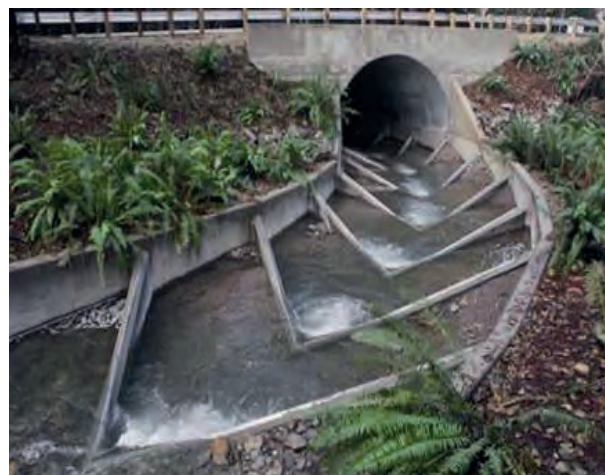
Рис. 2. Кульверты со специальными устройствами на нерестовых водотоках (США, 2004 г.): а – с внутренними перегородками; б – с рыбоходом
