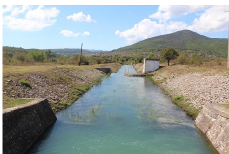
Рис. 4. Водоотводящий канал водозаборного сооружения Чернореченского водохранилища
