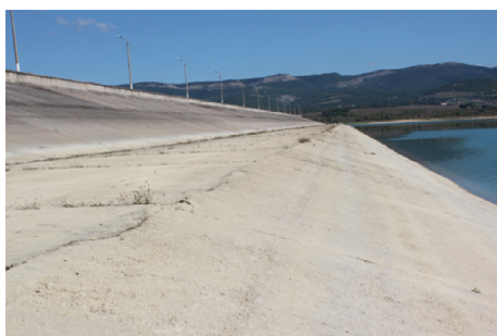
Рис. 1. Верховой откос плотины Чернореченского водохранилища, крепление выполнено ж/б плитами
