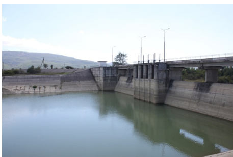
Рис. 3. Подводящий канал и водосливная плотина водосбросного сооружения Чернореченского водохранилища (вид с верхнего бьефа)
