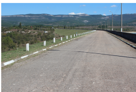
Рис. 2. Гребень плотины Чернореченского водохранилища
