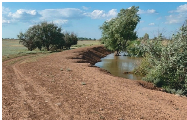
Рис. 2. Места зарастания профиля канала, а также обрушивания откосов вследствие использования канала в качестве водоема для крупного рогатого скота
