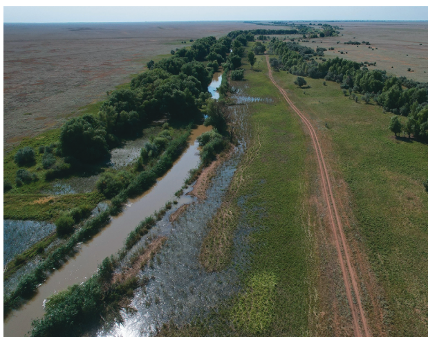
Рис. 4. Места перелива воды через гребень канала
