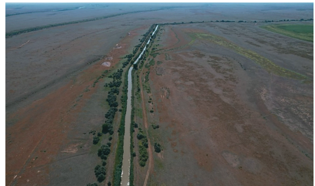
Рис. 1. Канал РЗ. Приемлемое состояние канала на данном участке
