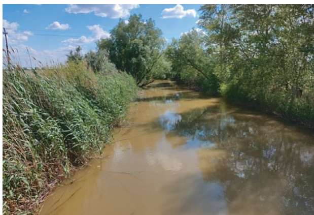
Рис. 3. Места интенсивного зарастания откосов канала деревьями
