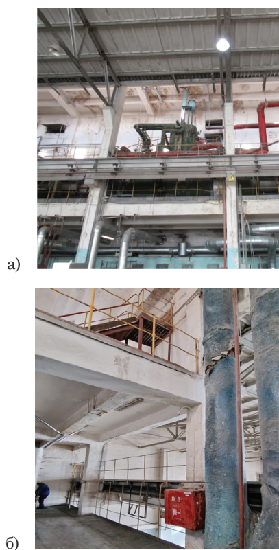
Рис. 3. Общий вид колонн, подкрановых балок и покрытия главного корпуса (а); железобетонный каркас здания деаэрационной этажерки (б)
