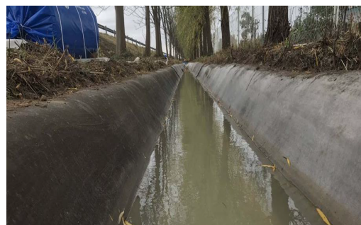
Рис. 3. Применение бетонного полотна марки BeNotex SK для укрепления водных объектов: а – укрепление канала; б – покрытие дорожных кюветов (фото С.Н. Щукина)
