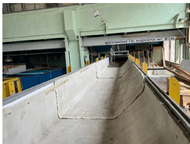
Рис. 5. Экспериментальная модель участка канала с бетонным покрытием из полотна BeNotex SK перед пуском (фото Т.Ю. Жуковой)
