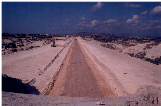
Рис. 2. Плотина «Сахаби» (САР) на этапе строительства (русло реки «Beit Yashut»)
