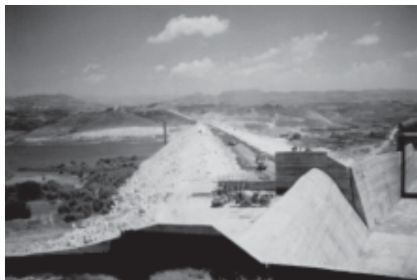
Рис. 1. Плотина «Саура» (Сирия) на этапе завершения строительства: H = 78 м
