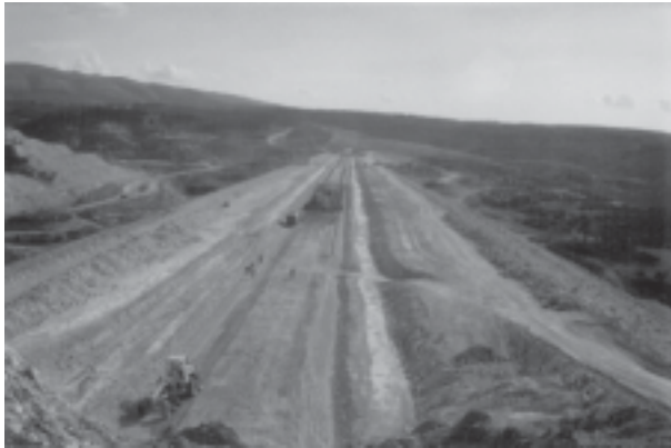
Рис. 2. Плотина «Сахаби» (Сирия) на этапе строительства: H = 68 м
