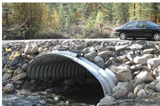
Рис. 2. Оптимальные способы устройства кульвертов в лососевых ручьях:
