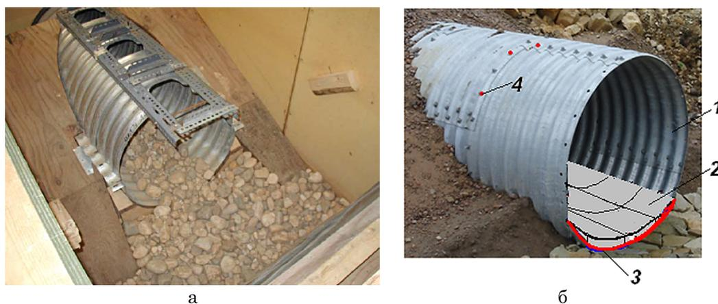
Рис. 4. МГТ с каменной отсыпкой (а) и гладким лотком (б) на дне:
