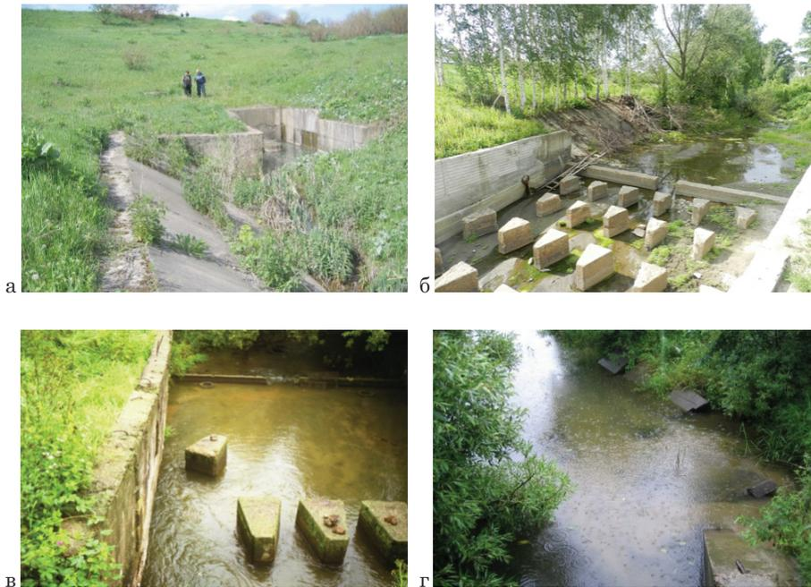
Рис. 1. Разрушение крепления нижнего бьефа водопропускных ГТС АПК, возведённых по типовым проектам (фото авторов):
