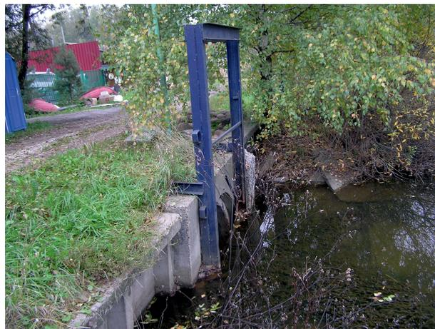
Рис. 2. Входной оголовок трубчатого водосброса на плотине Нижнего Виноградовского (Долгого) пруда
