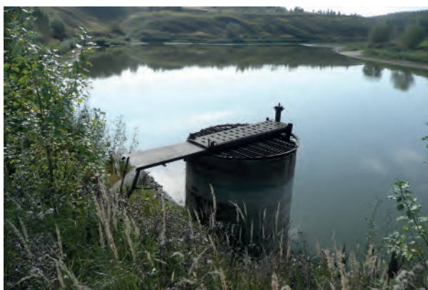
Рис.3. Трубчатый водосброс с цилиндрическим башенным оголовком с переливом по всему периметру, совмещенный с донным водовыпуском с плоским затвором: а – общий вид входного оголовка и нижнего пруда 20.09.2012; б – схема входного оголовка; 1 – тело плотины; 2 – башенный оголовок водосброса; 3 – отводящая труба; 4 – горизонтальная сороудерживающая решетка; 5 – подходный мостик; 6 – плоский затвор донного водовыпуска; 7 – подъемник
