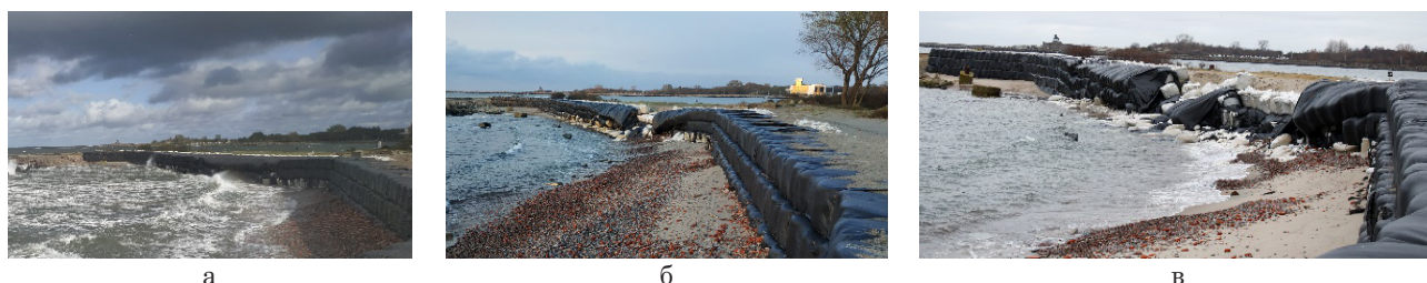
Рис. 3. Повреждение искусственной авандюны из биг-бэгов (сегмент укрепления севернее исторического форта «Западный»):
