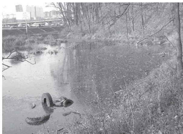
Рис. 3. Вид с левого берега (со стороны главного дома) на оставшуюся часть водной системы из пяти прудов усадьбы Братцево, разрушенной при строительстве МКАД (2006)
