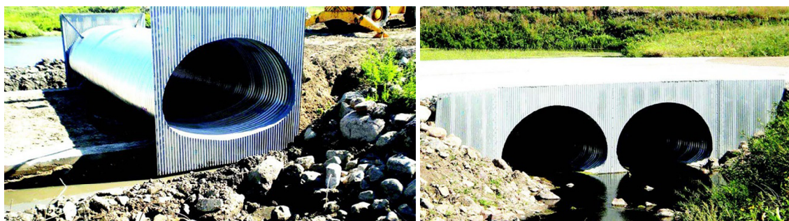
Рис. 1. Двухочковые гофрированные трубы CSP диаметром d = 3 м, заменившие 4-х очковый трубчатый переход из железобетона ( d = 1,2 м) за 1 неделю на нерестовом водотоке: р. Бивер-Крик – приток р. Миссури, округ Эммонс, штат Нью-Йорк, США, проект TrueNorth Steel, 2019 г.
