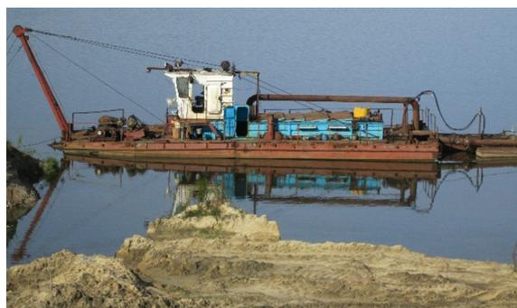
Рис. 4. Рабочий этап возведения защитной дамбы с разработкой донных отложений землесосным снарядом
