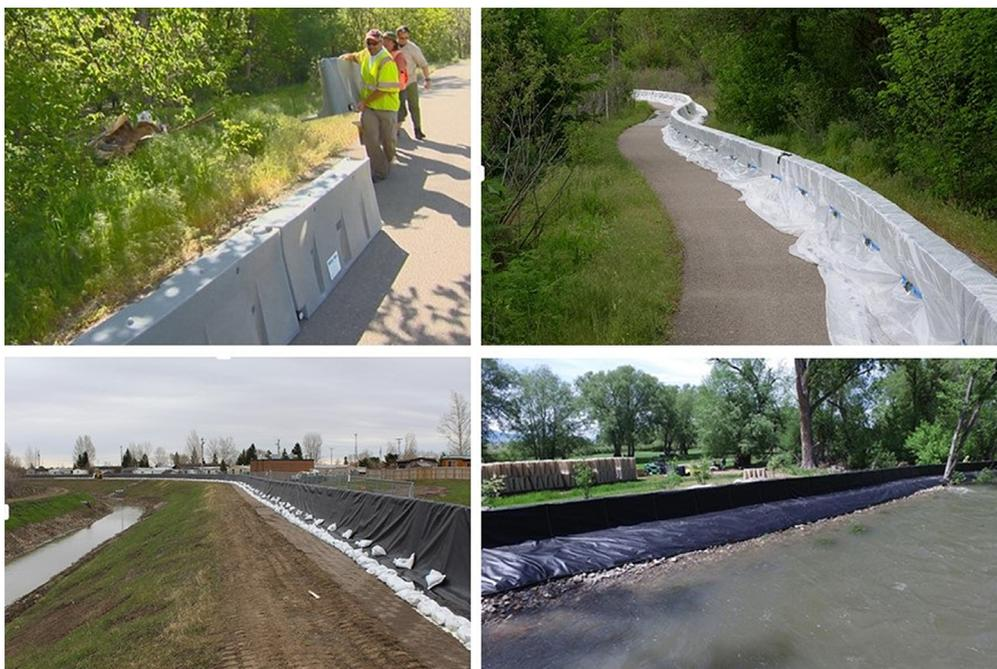
Рис. 1. Средства противопаводковой инженерной защиты быстрого разворачивания
