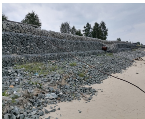
Сооружение габионного типа (поселок Выкатной) Gabion-type structure (Vykatnaya settlement)
