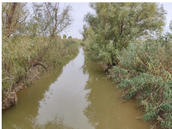
Рис. 4. Интенсивное зарастание откосов канала
